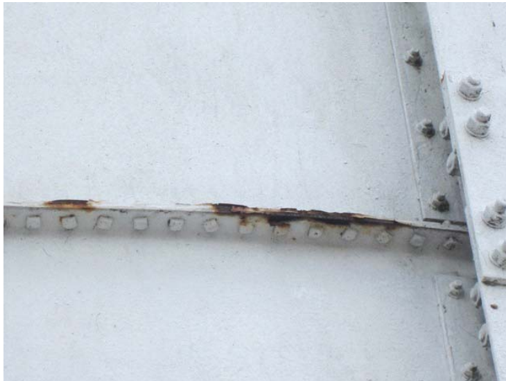
Edge corrosion
