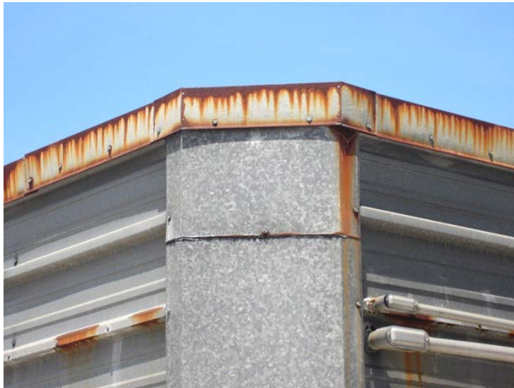
Edge corrosion
